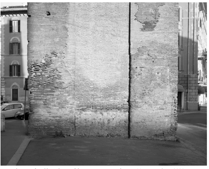
Acquedotto Claudio (dettaglio), Porta Maggiore, 11 settembre 2020
